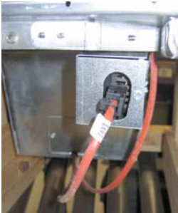
Şekil 6 İki pinli beyaz konnektörü tutturun ve siyah fişi şekilde 6 'da gösterildiği gibi buata takın. * Siyah fişin takılma yerinin resimdeki farklı olabilir.
